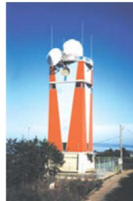
布津町にあるレーダー雨量計。レーダー雨量計は、降っている雨に電波を当て、はね返ってくる電波の強さから雨の降り方を観測するもので、雨の強さ、雨域の広がり、その動きを連続的に知ることができ、降雨の予測などに利用できます。
